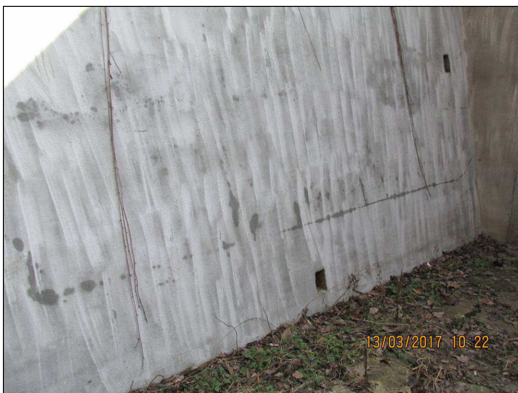
Obr. č. 4 - pohled zleva na křídlo směrem Kuřim - průsaky vody skrze konstrukci
