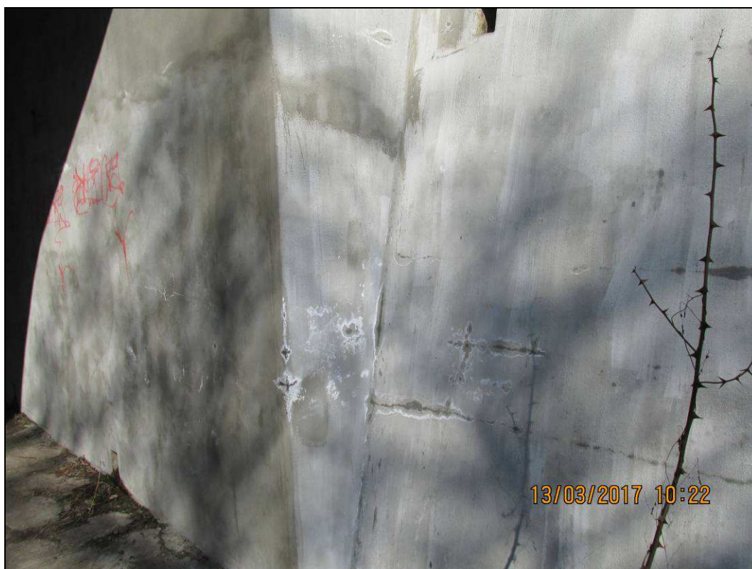
Obr. č. 3 - pohled zprava na opěru a křídlo směrem Kuřim - průsaky vody skrze konstrukci
